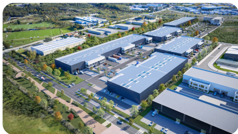
Nexity : Construction de bâtiments mixtes activité-bureaux Opération Urban'East Parc Act'Y 2 - 16 000 m 2 © Schwab Architectes
